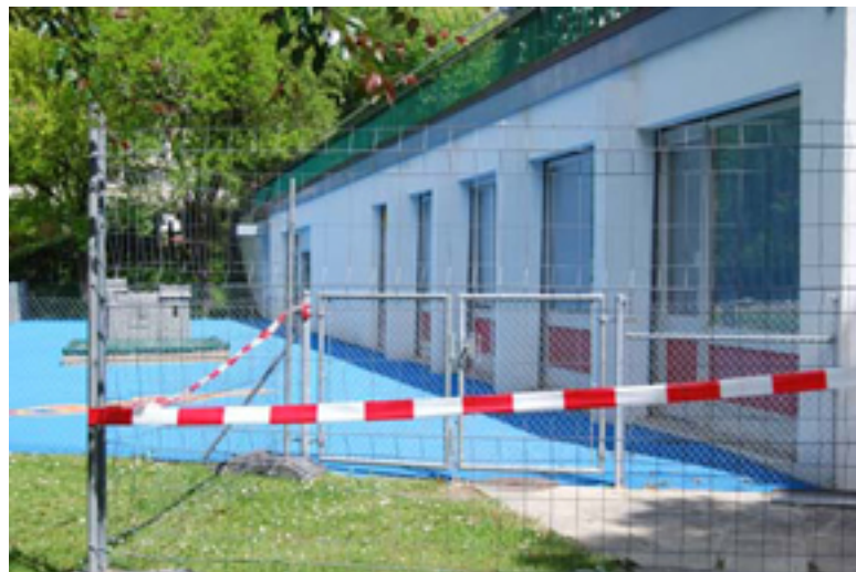
Le « Petit Manège » a été transformé et rénové d'avril à août 2014.
