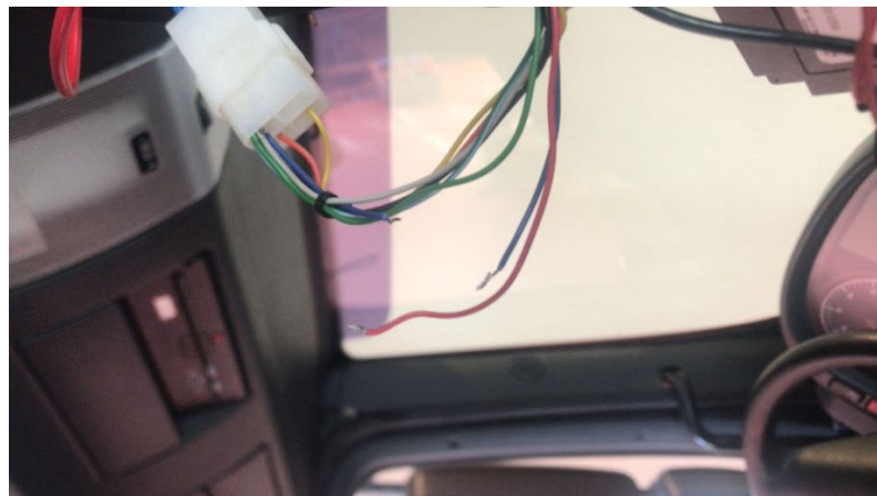
Véhicule 21-11 : Fils dénudés et non raccordés dans le véhicule, empêchant l'enregistrement des données de manière correcte selon les directives en vigueur.
