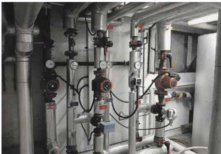
Système de chauffage à distance.
