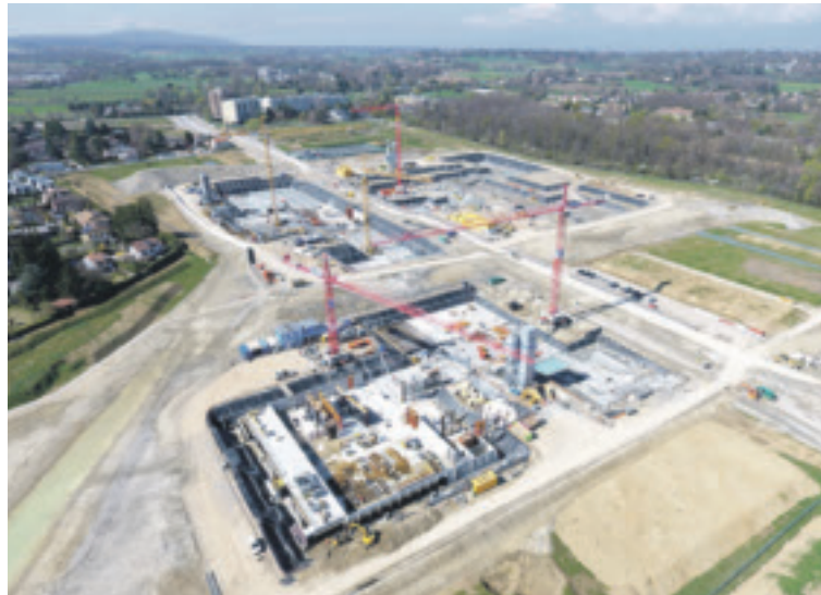
Lors du "Café Chantier", les visiteurs ont pu prendre la mesure de l'ampleur du chantier.
