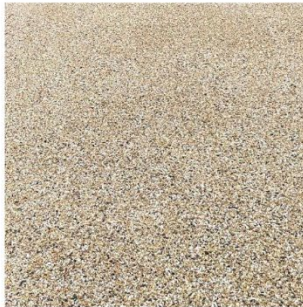
Enrobé drainant (type COLDRAINE®) adapté PMR
