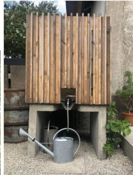
la citerne d'eau de pluie
