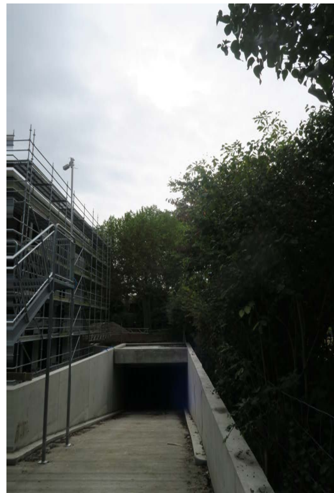
Chantier de densification en zone villas Avenue Marc-Doret _Maëlle Proust Automne 2020
